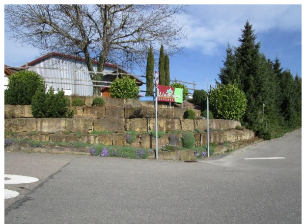
Abb. 12: Natursteinmauer an der südlichen Anschlussstelle zum Plangebiet (Stand 2021)
